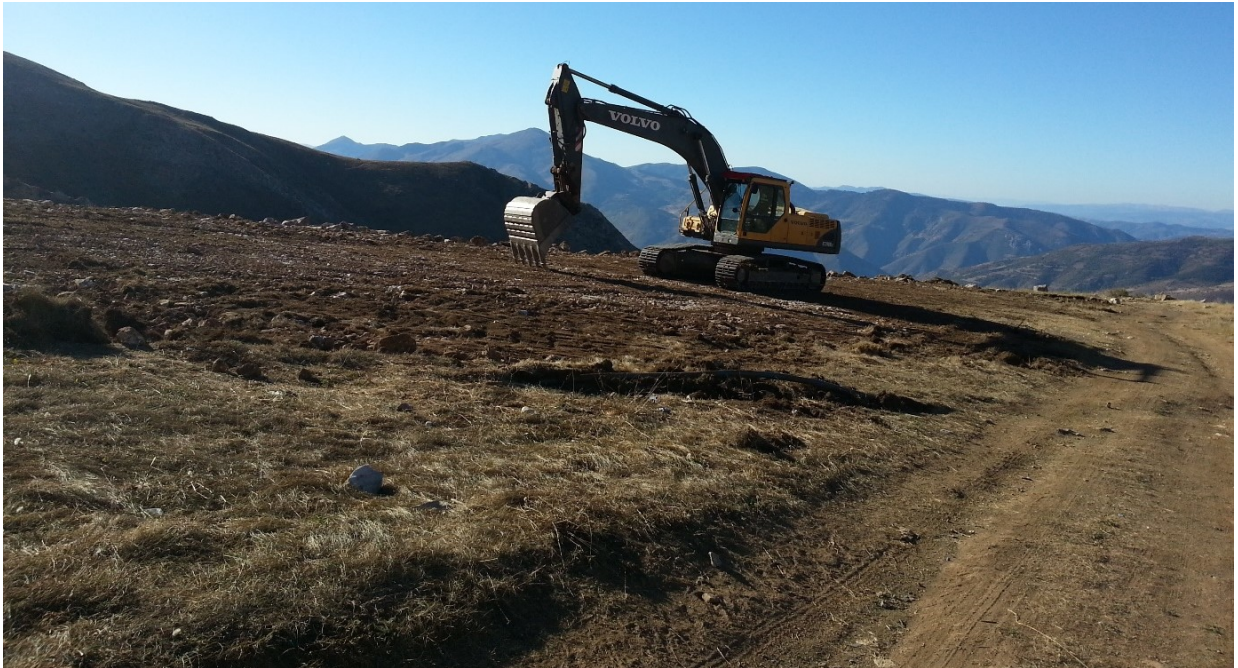
Etkinlik alanı tesviye çalışmaları
